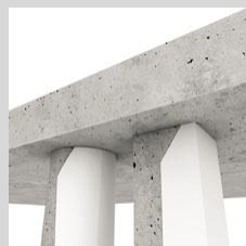
betónové nosníky, stĺpy a steny
